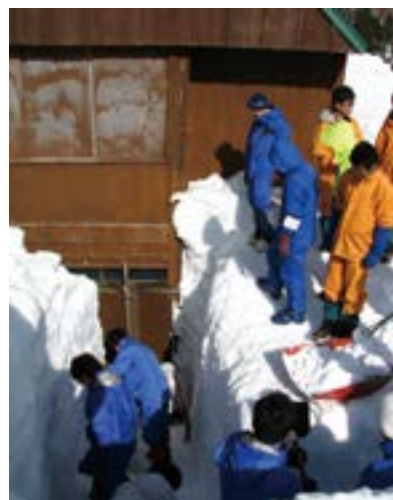
小屋入口の掘り出し作業
