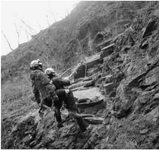
ワイヤーによる吊り下げ
